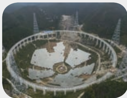
裝嵌反射金屬鏡面，由 4,450 塊三角形半透明金屬網組成
