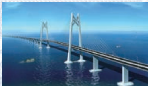
青州航道段鋼索斜拉橋，全長458米，兩個中國結橋塔，寓意「三地同心」
