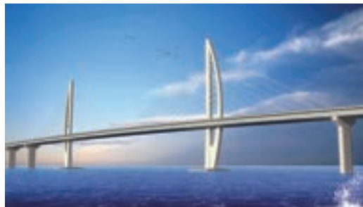
九洲航道段鋼索斜拉橋，全長268米，2個風帆橋塔，寓意「揚帆遠航」
