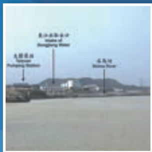
石馬河調污工程2005年完成，用一道橡膠壩阻截石馬河污水從太園泵站取水口附近流入東江，保證輸港東江水水質
